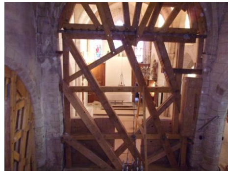
Renforcement de la structure à l'intérieur
